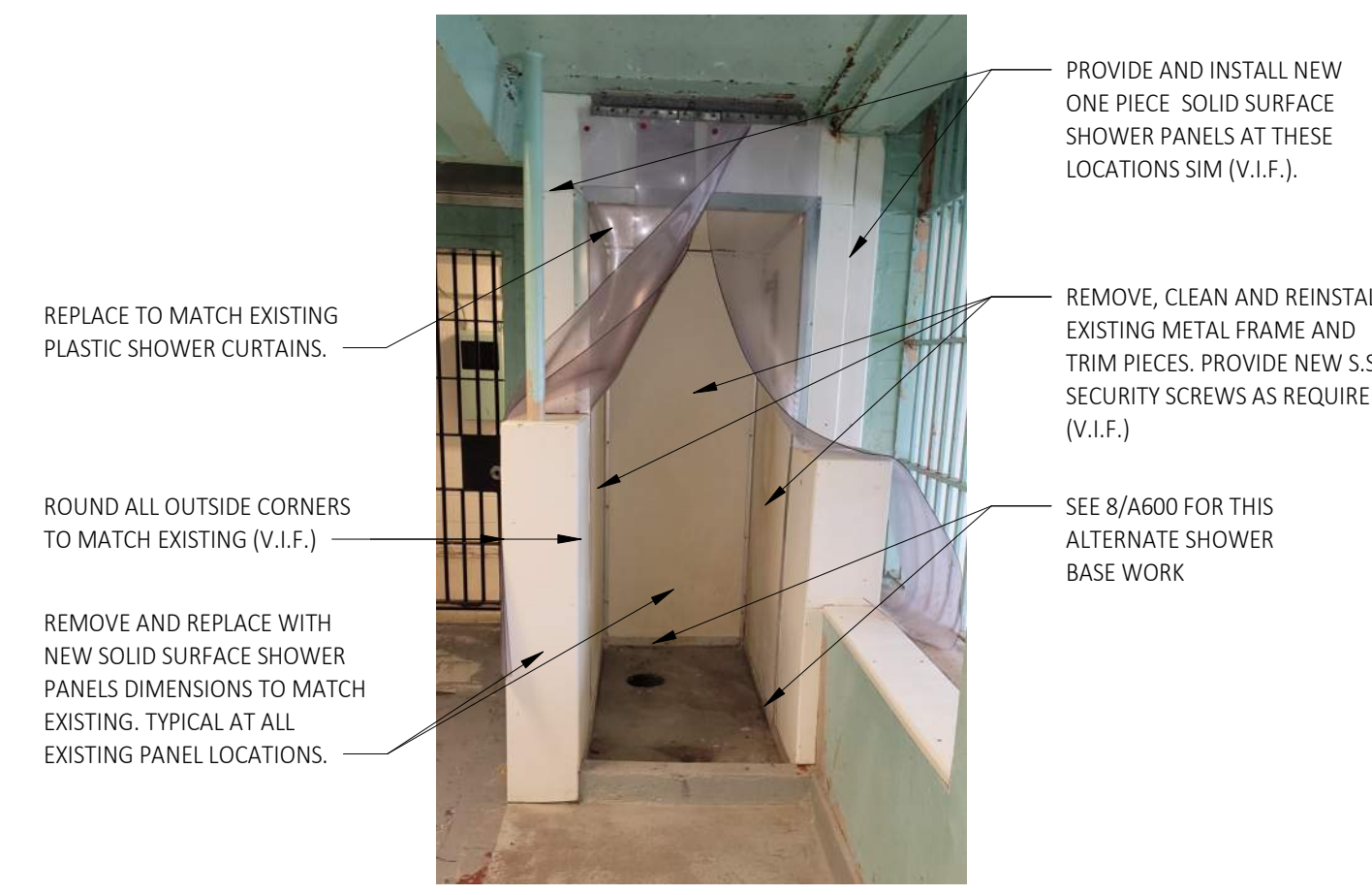
12 A600 Shower Enclosure Replacement Alternate 1,3,5 & 10 SCALE: N.T.S.
